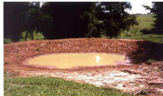
Abertura de bacias de contenção
